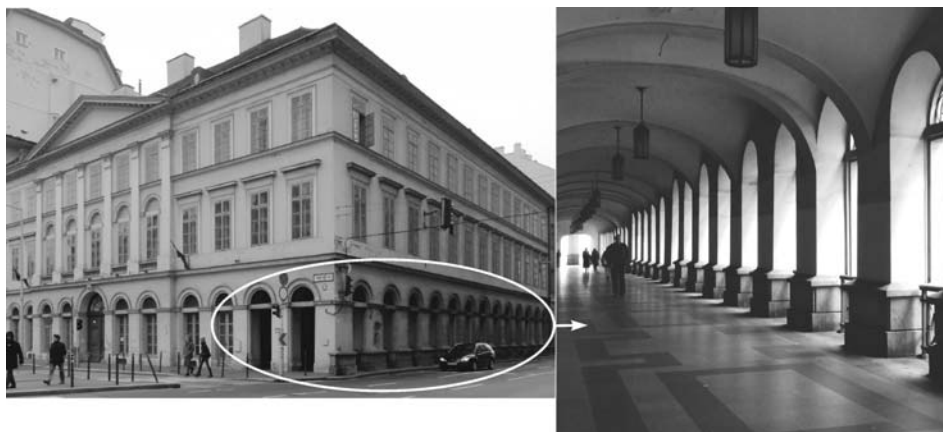
8. ábra. A földrengés-biztonság gyengítése árkádsor kialakításával
