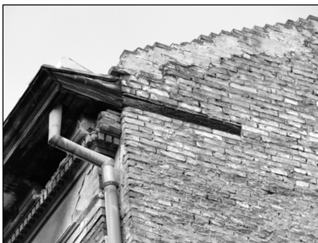
6. ábra. Felső párkány és a fedél rögzítése a Szentkirályi utcában
