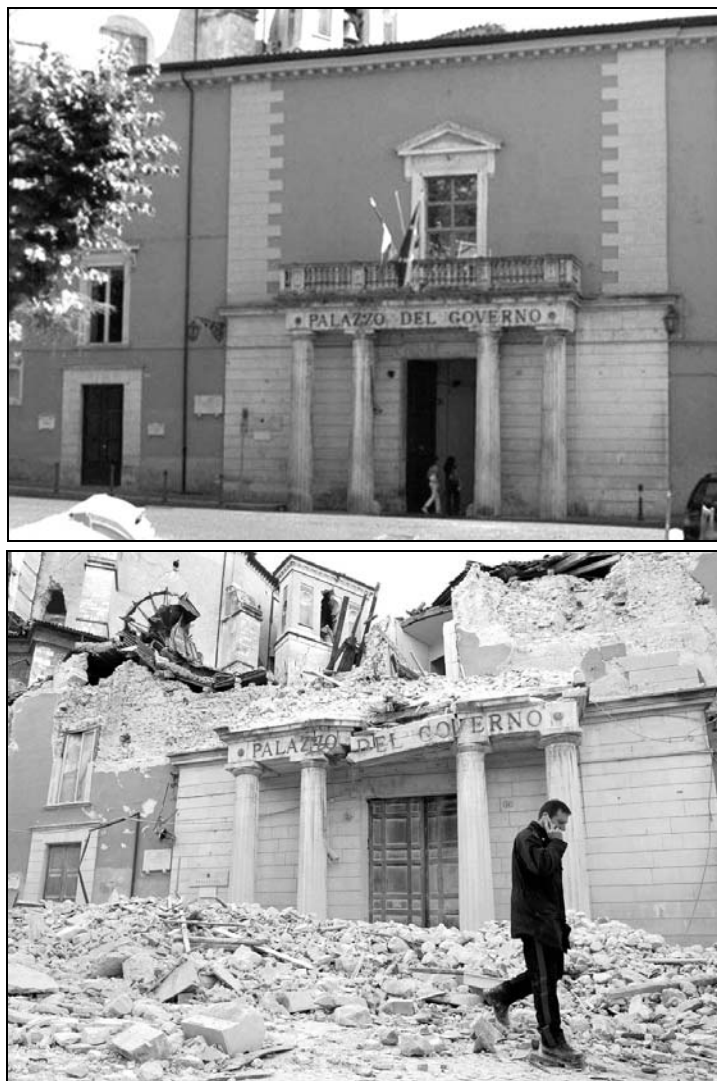
14. ábra. L'Aquila-ban a Kormányzó Palota a földrengés előtt és után (forrás: www.telegraph.co.uk/news/picturegalleries )
