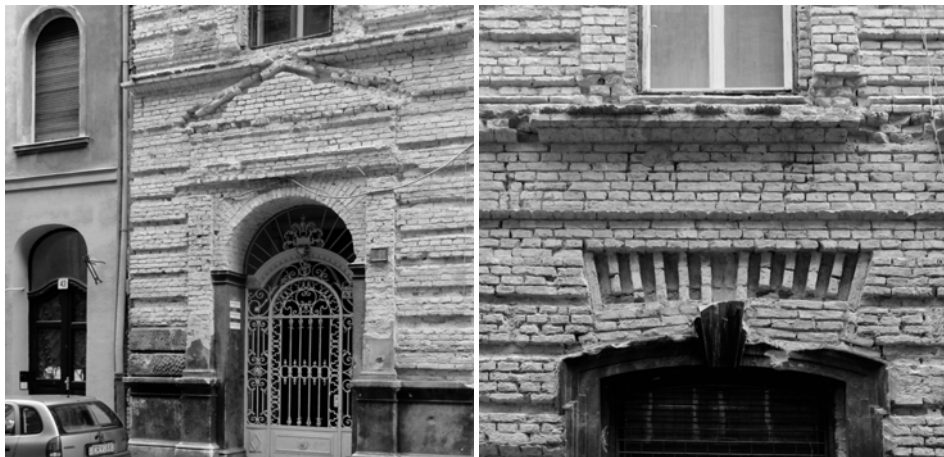
7. ábra. Boltíves szerkezetek és áthidalások a Paulay Ede utcában
