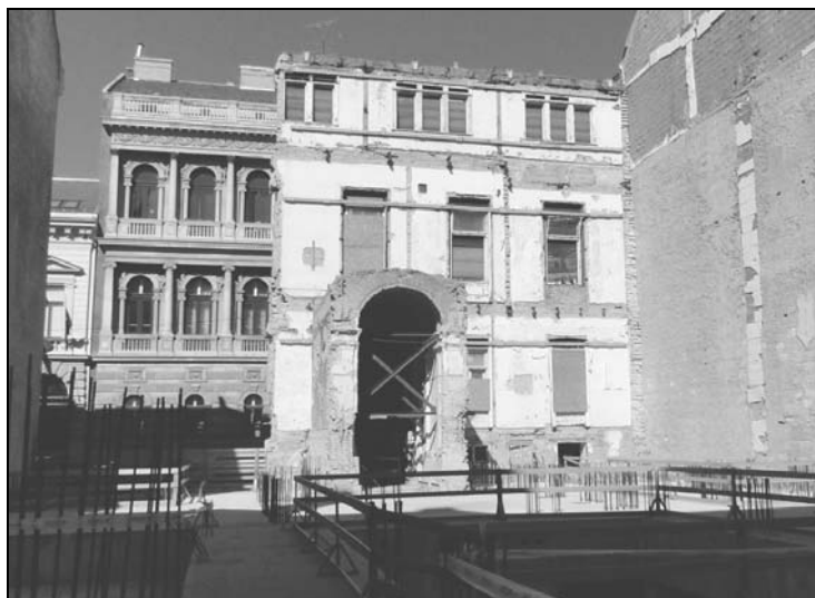
17. ábra. A felső képen az utcafronti ideiglenesen megtámasztott eredeti téglafal, alatta a belső vasbetonszerkezetes építkezés az Eötvös utcában
