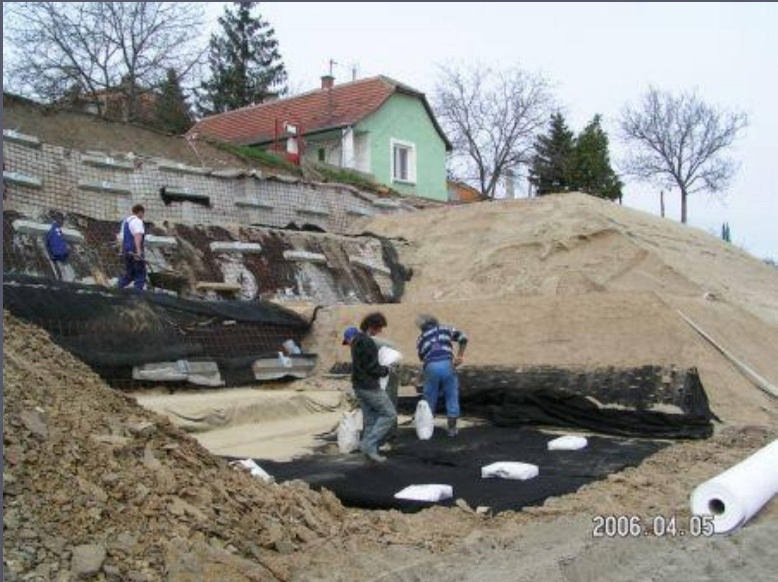
Ercsi támfal készítése 2006-ban bekövetkezett omlás után (fotó: Sycons Építőipari Kft.)
