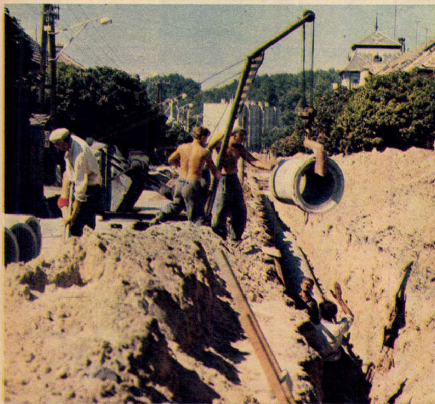
Épül a csatorna az Ady Endre utcában. Ez is téma volt a jelölőgyűléseken
